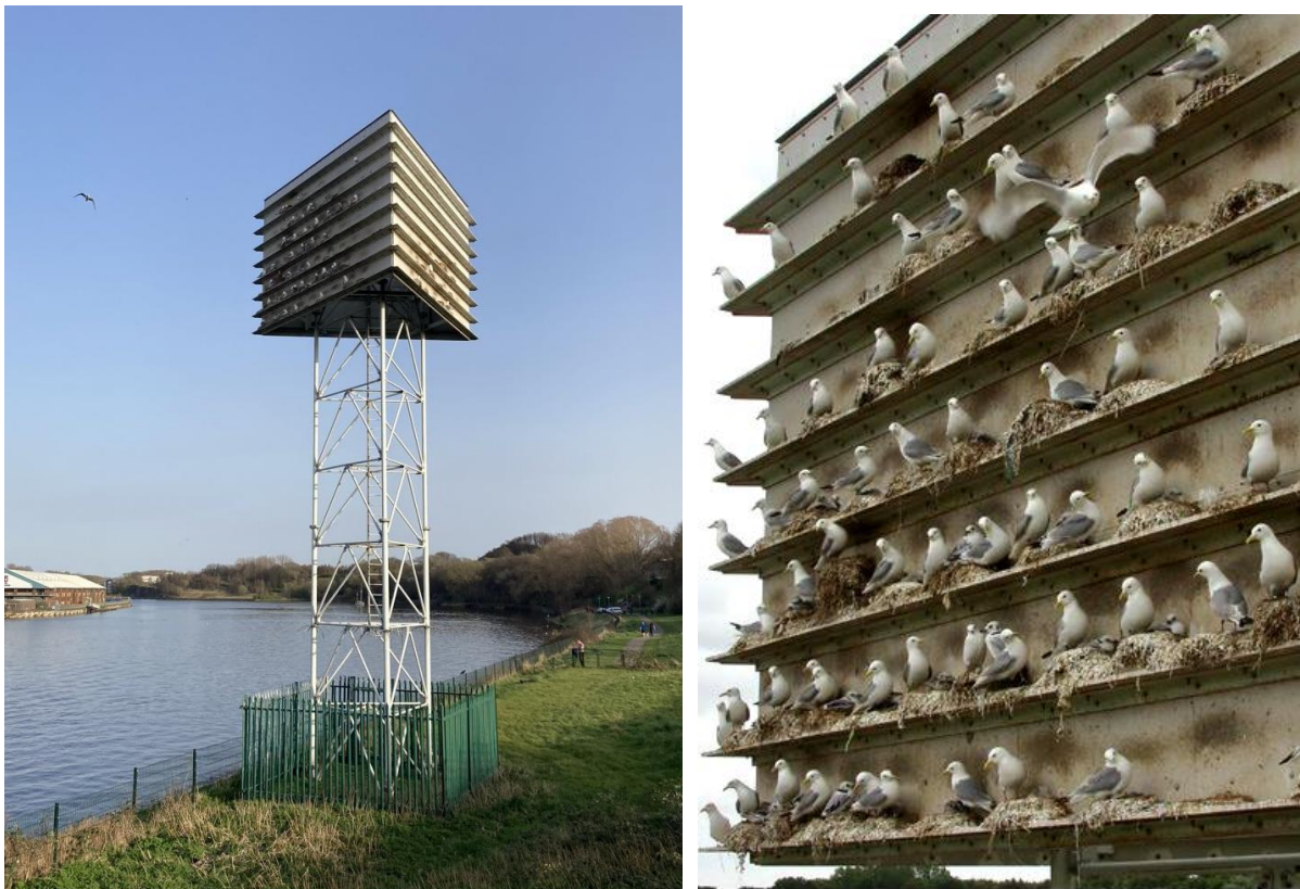
Figuur 3.2 - Overzicht van de Saltmeadows Tower (links) en detail van één van de drie broedwanden met houten nestrichels en broedende drieteenmeeuwen (rechts). De toren is ontworpen als kunstmatige broedstructuur ter vervanging van verloren nestgelegenheid. Bron: Andrew Rickeard
