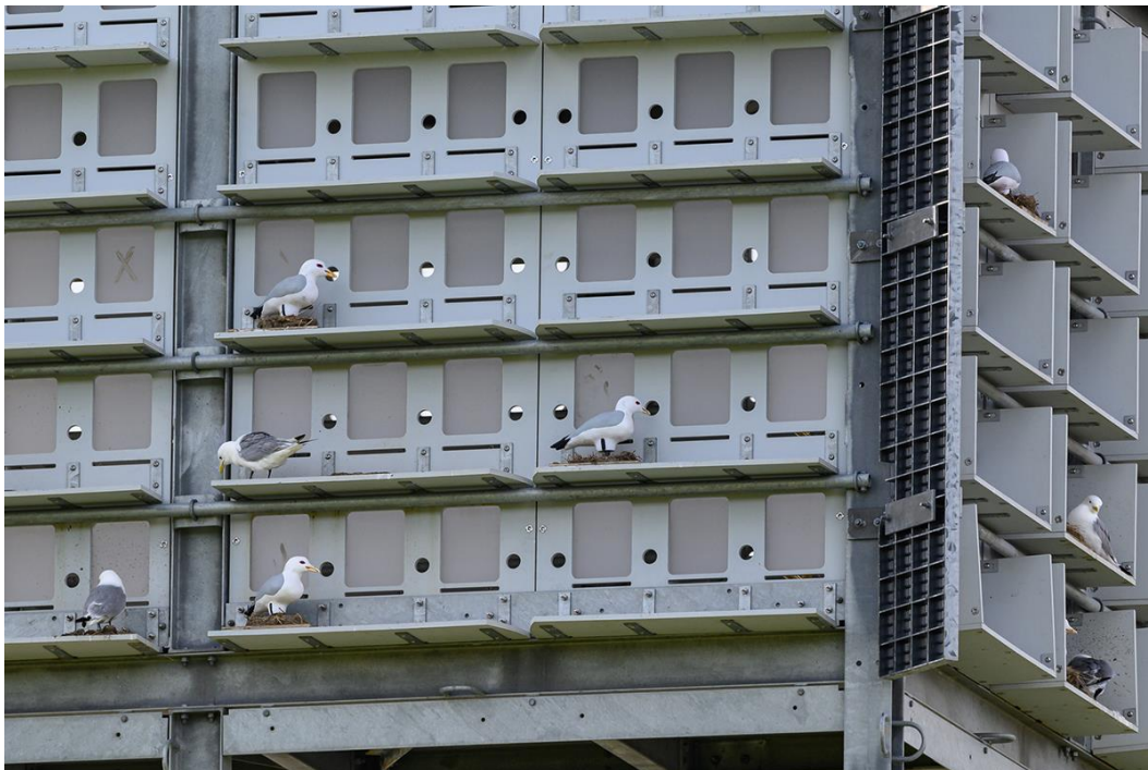
Figuur 3.4 - Detail van de Kittiwakery met de verschillende typen broedvoorzieningen (lineaire richels en nestboxen die zijn ontworpen om de voorkeuren van drieteenmeeuwen te onderzoeken) en lokvogels (geplaatst om prospecterende drieteenmeeuwen aan te trekken en kolonisatie van de structuur te stimuleren) . © Martin Kitching/Shoney Wind.
